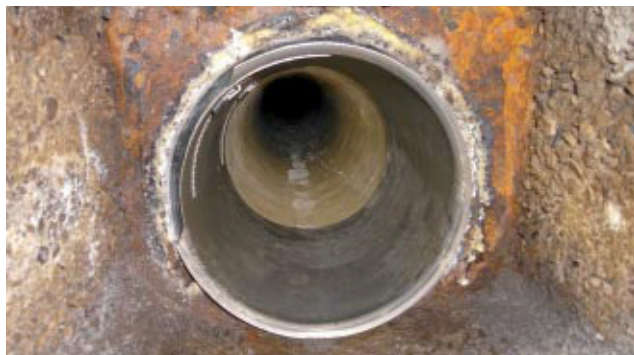
MANICOTTO QUICK-LOCK END IN ACCIAIO INOX E GOMMA EPDM PER IL FISSAGGIO E LA PROTEZIONE DELLE ESTREMITÀ DELLA GUAINA APPENA POSATA
