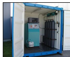
Container per compressore Interno
