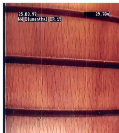
Filtro di pozzo dopo rigenerazione mediante procedimento hydropuls®
