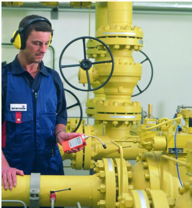
L'EX-TEC Snooper 4 è uno strumento per la rilevazione di fughe gas di minima entità.
