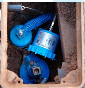
costruzione compatta e robusta (connettori militari, IP68) per installazione in camerette di piccole dimensioni (tipo Atplas)
