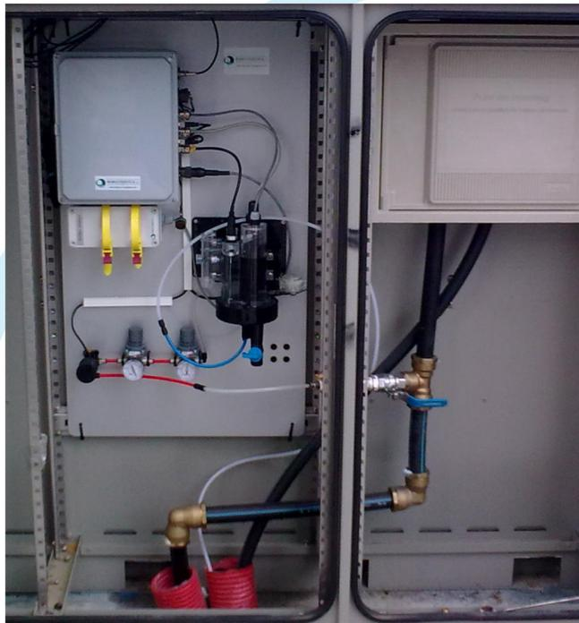
Creato per i gestori delle reti idriche, l'analizzatore Athenea consente di monitorare la qualità dell'acqua in modo completamente autonomo, riducendo così la necessità di lunghi e costosi prelievi manuali sul posto, nonché la possibilità di errori operativi.
